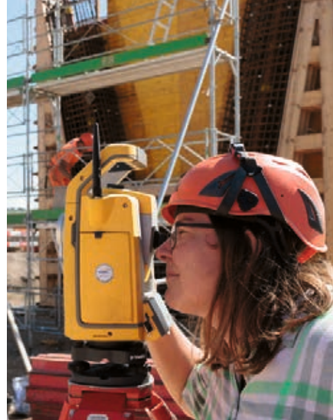
^ L'ingénieure contrôle la position des éléments d'un coffrage grâce à sa station totale, avant le coulage du béton.
